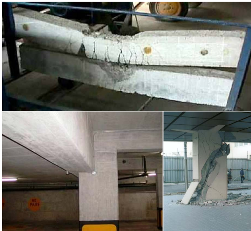
Figura 1.1: Estructuras sometidas a esfuerzo cortante.
